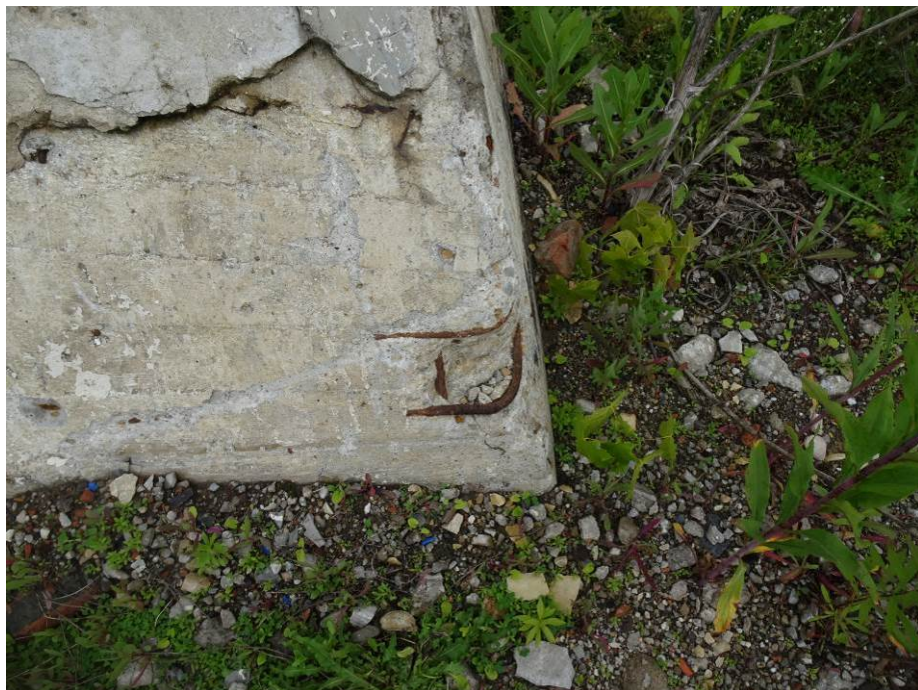
Rys. 34. Korozja zbrojenia na fundamencie zachodnim
