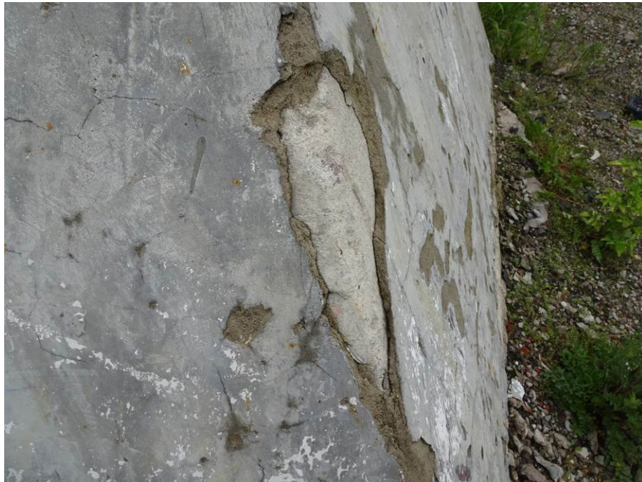
Rys. 35. Odspojona powłoka naprawcza na fundamencie wschodnim
