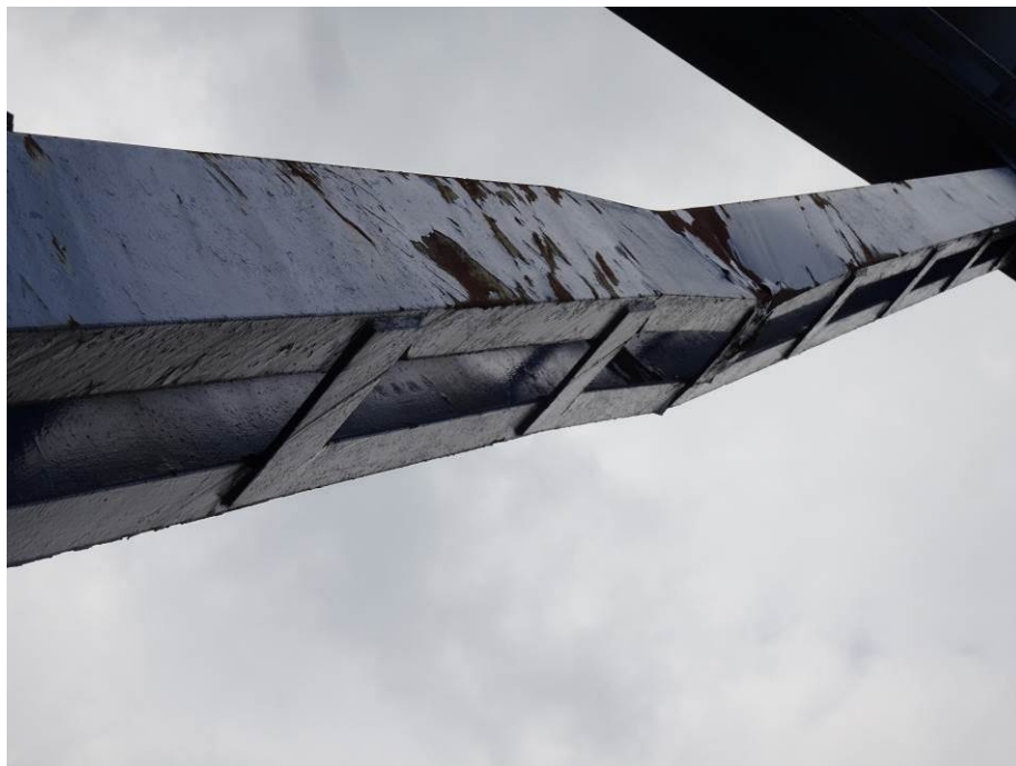
Rys. 27. Deformacja dolnego zastrzału skosu
