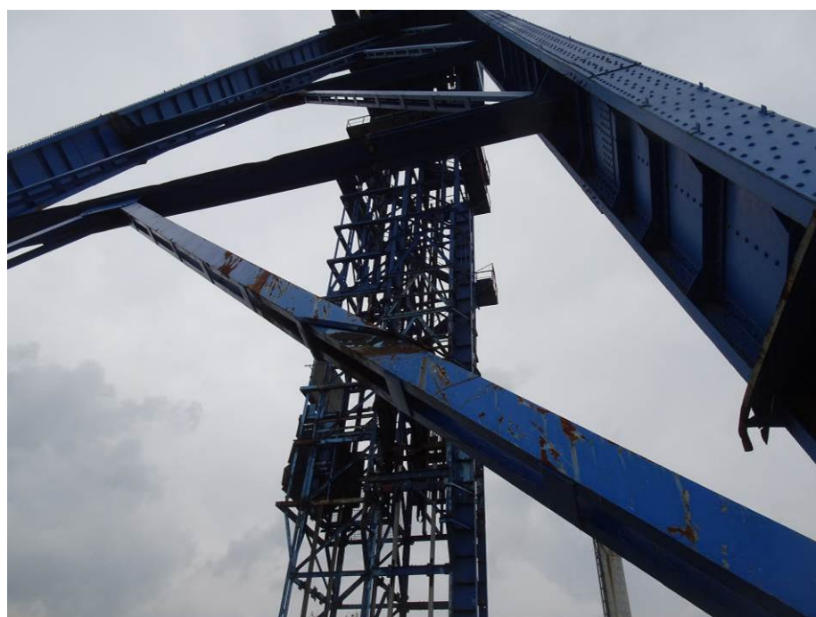
Rys. 24. Lokalne uszkodzenia korozyjne skosu
