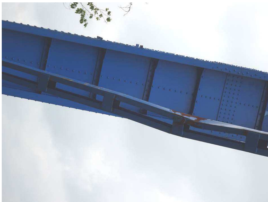
Rys. 28. Deformacja dolnego zastrzału skosu
