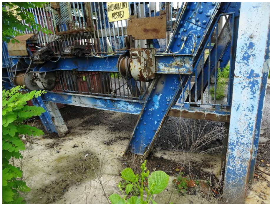
Rys. 20. Lokalne uszkodzenia korozyjne elementów wieży przewodniczej
