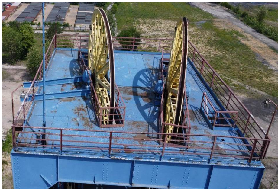
Rys. 42. Widok od strony południowej. Lokalna korozja
