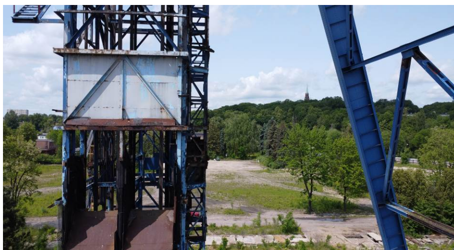
Rys. 56. Widok od strony wschodniej. Lokalna korozja
