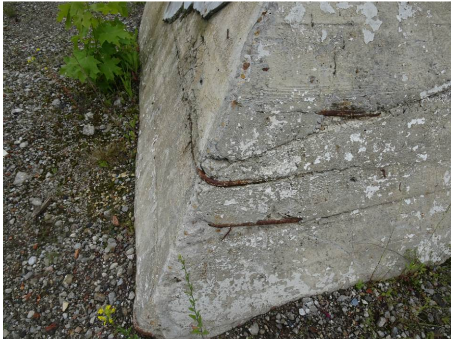
Rys. 33. Korozja zbrojenia na fundamencie zachodnim
