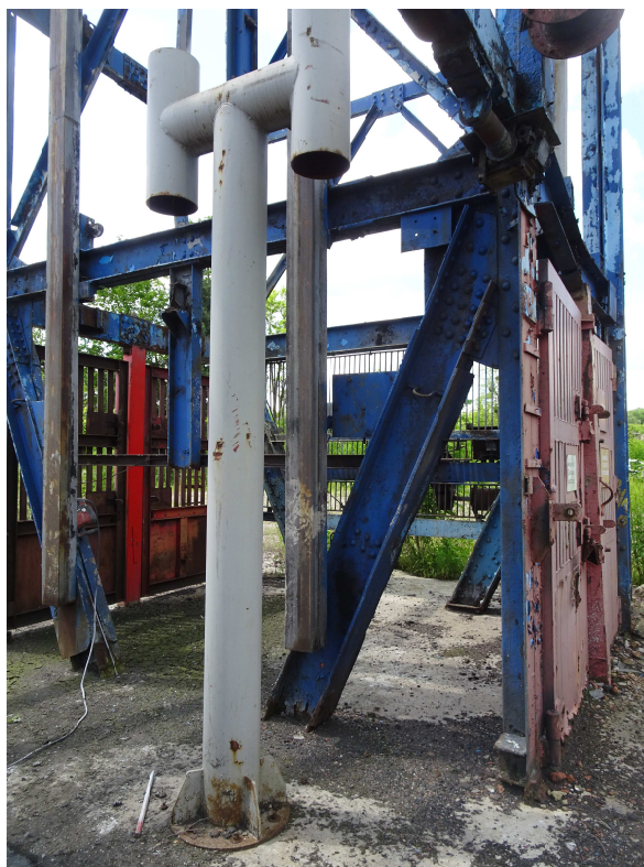
Rys. 46. Komin wentylacyjny na betowej czapie szybu
