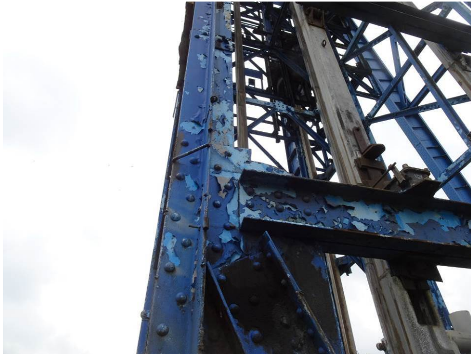
Rys. 29. Zużyte powłoki malarskie na powierzchni elementów wieży przewodniczej
