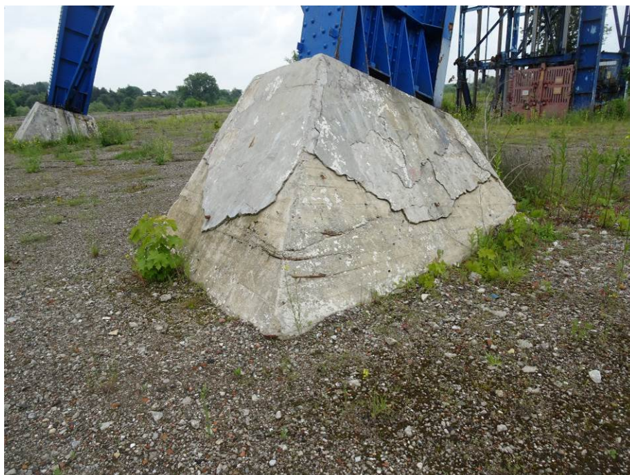
Rys. 32. Odspojona powłoka naprawcza na fundamencie zachodnim
