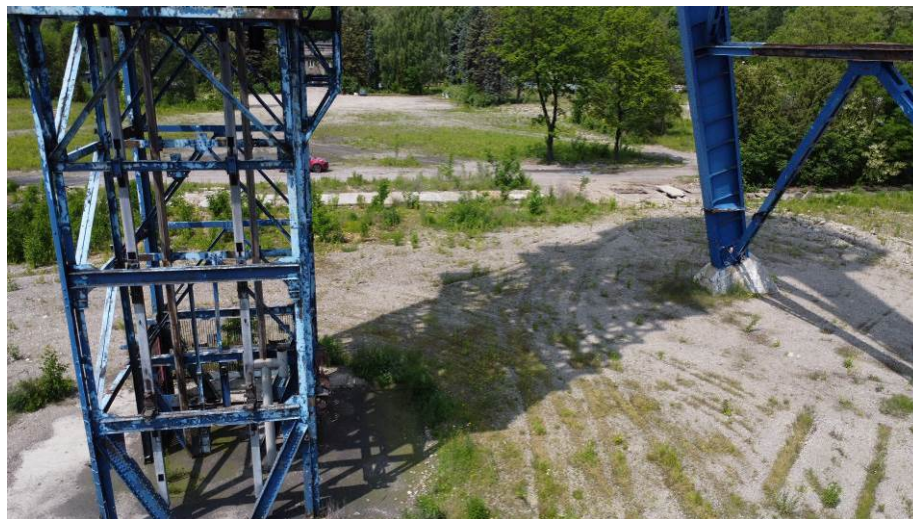
Rys. 57. Widok od strony wschodniej. Lokalna korozja
