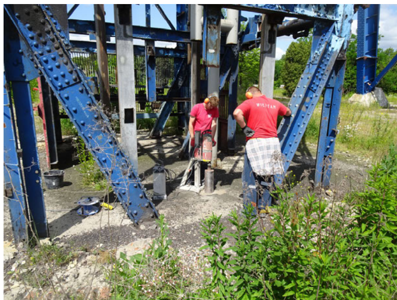
Rys. 44. Wykonywanie odwiertu rdzeniowego
