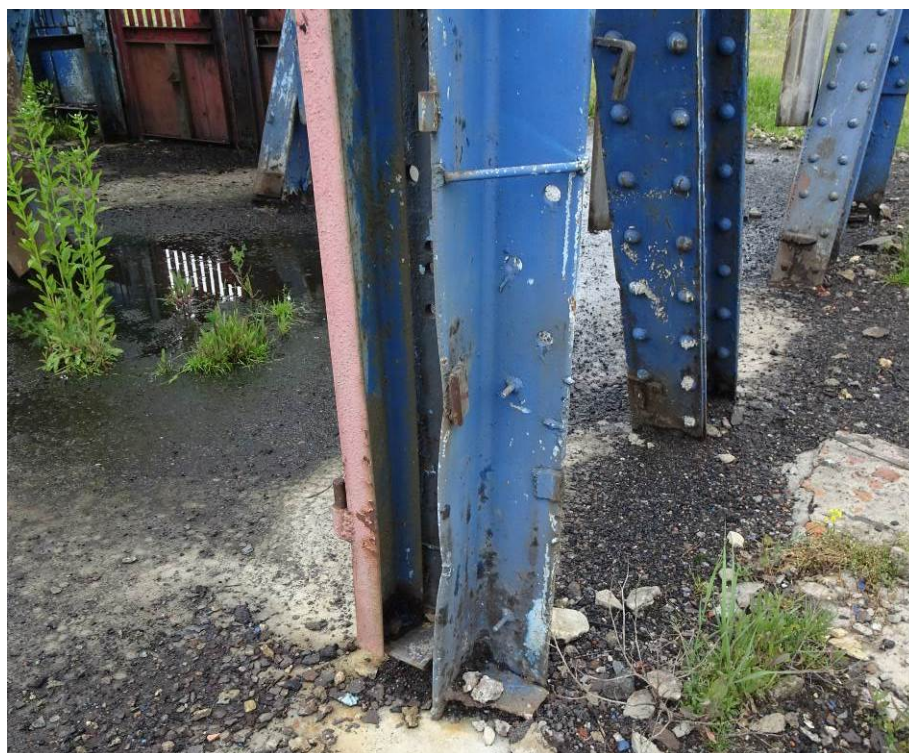
Rys. 26. Deformacja kątownika słupa wieży przewodniczej
