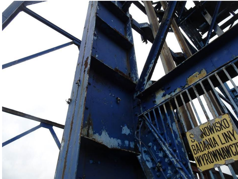
Rys. 21. Lokalne uszkodzenia korozyjne elementów wieży przewodniczej
