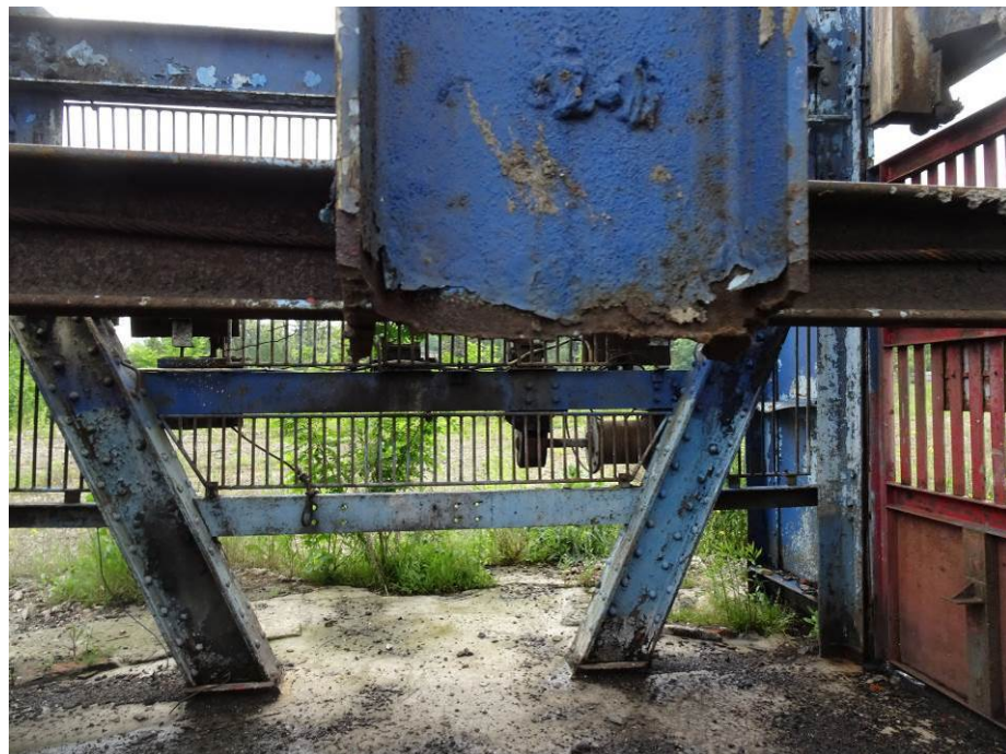
Rys. 22. Lokalne uszkodzenia korozyjne elementów wieży przewodniczej
