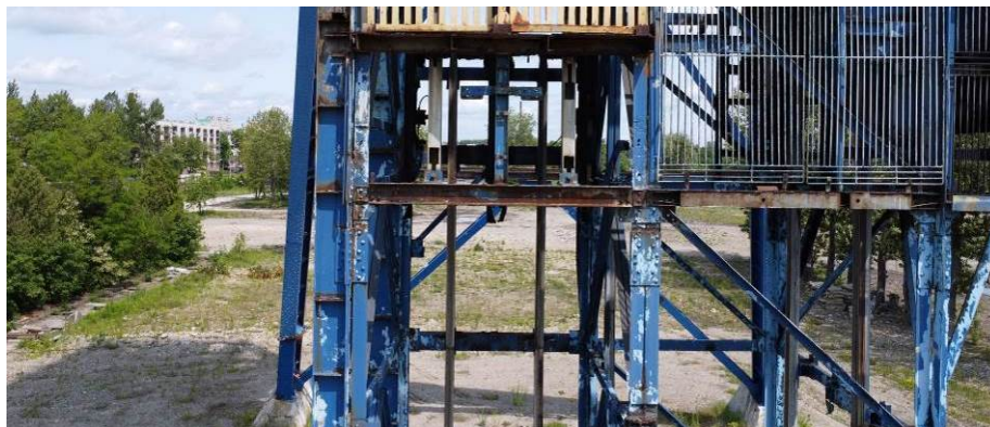
Rys. 48. Widok od strony południowej. Lokalna korozja
