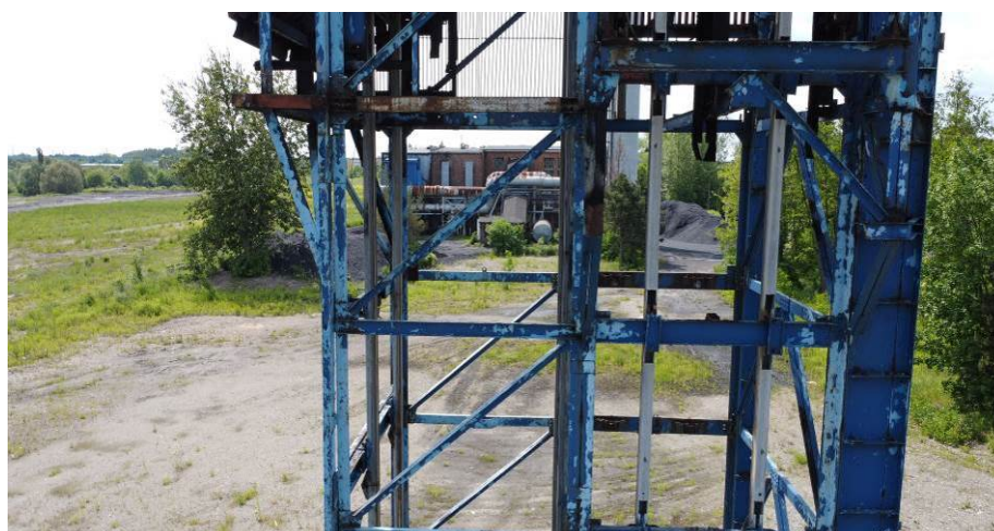
Rys. 63. Widok od strony północnej. Lokalna korozja
