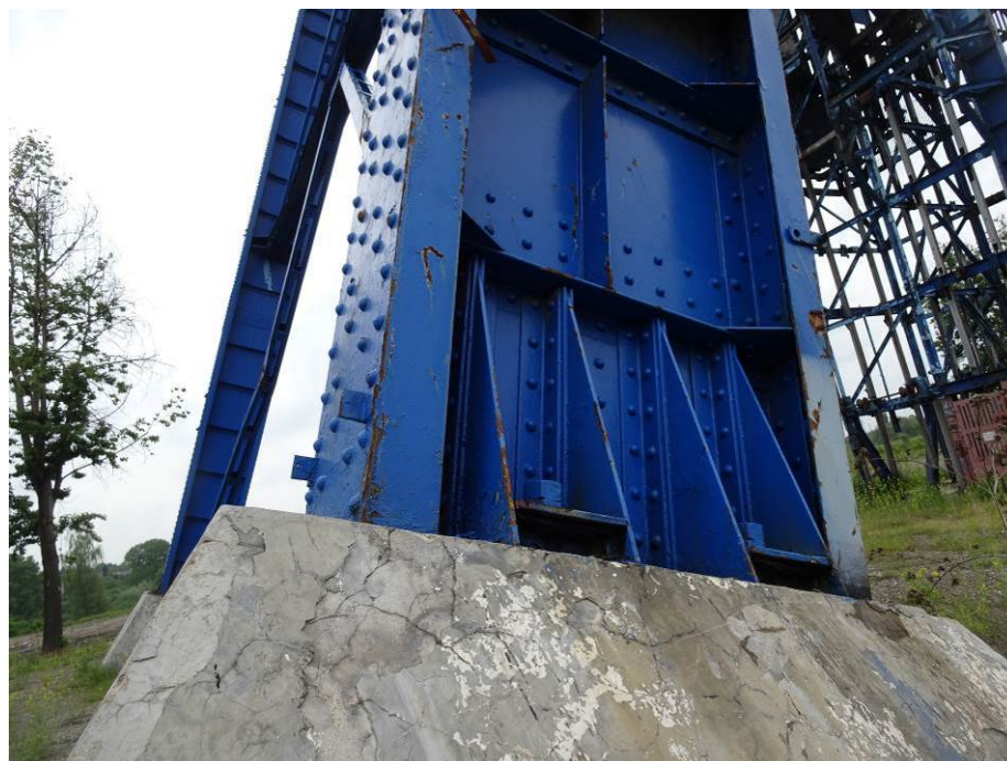
Rys. 23. Lokalne uszkodzenia korozyjne skosu
