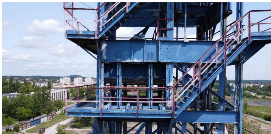
Rys. 45. Widok od strony południowej. Lokalna korozja i ślady po zaciekach
