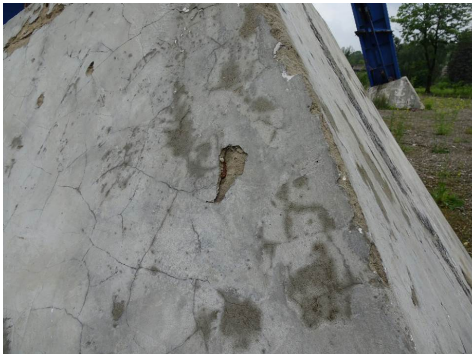
Rys. 36. Odspojona i zarysowana powłoka naprawcza na fundamencie wschodnim
