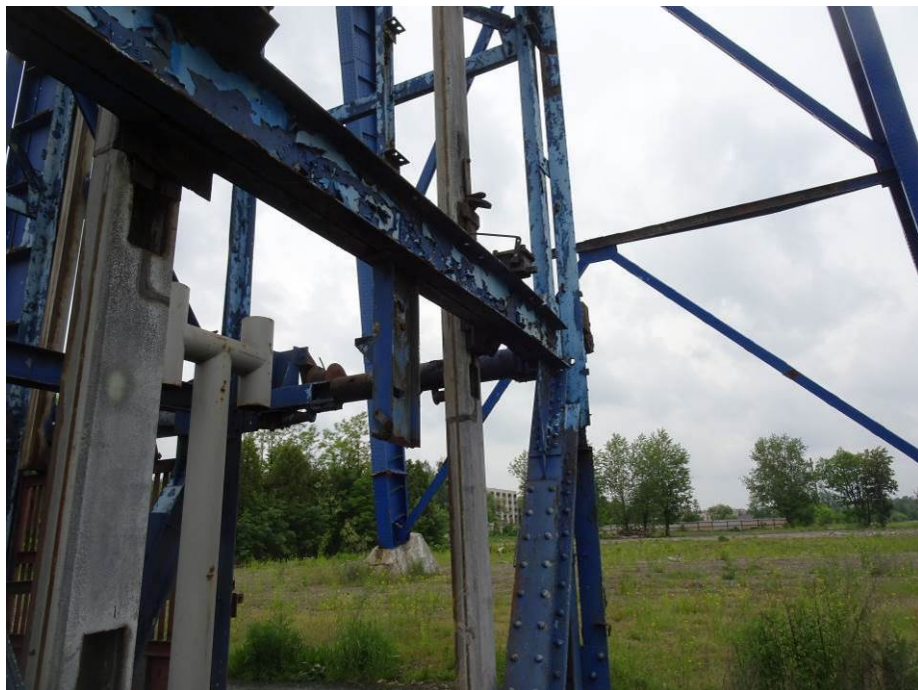
Rys. 30. Zużyte powłoki malarskie na powierzchni elementów wieży przewodniczej
