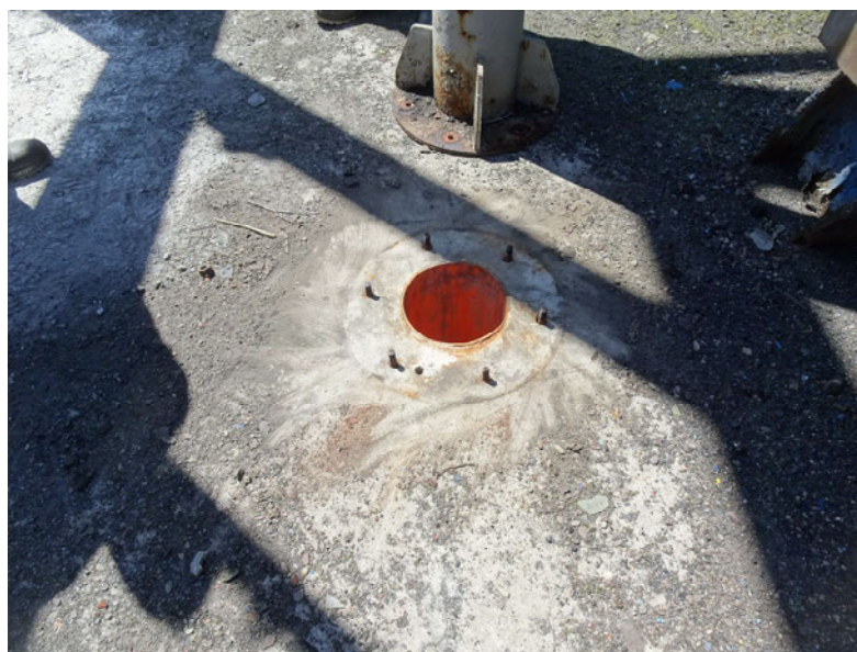
Rys. 47. Otwór po zdemontowanym kominie
