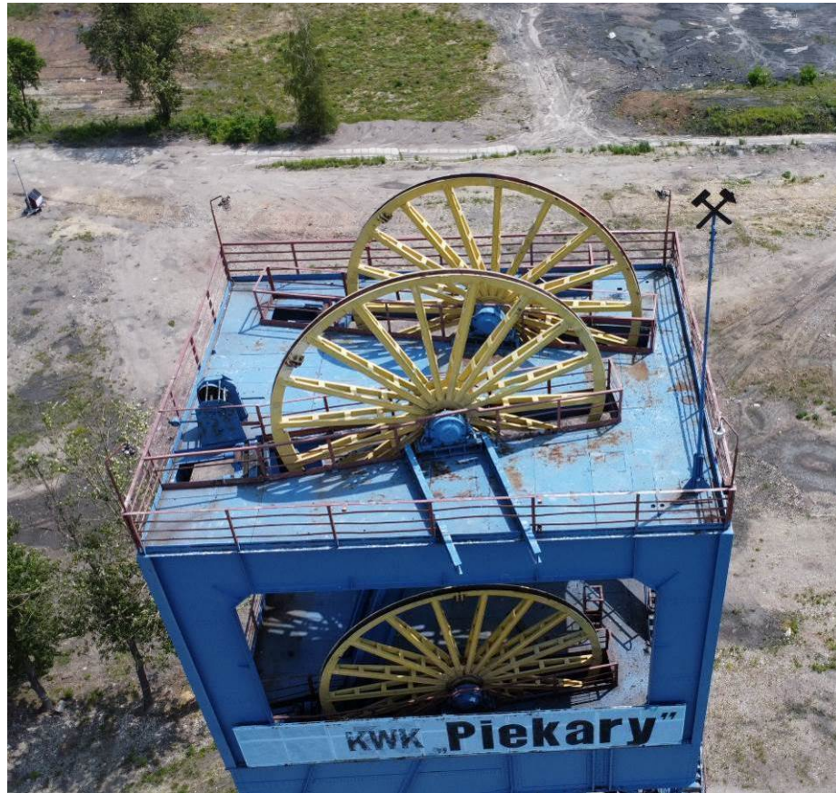
Rys. 37. Widok od strony zachodniej. Lokalna korozja
