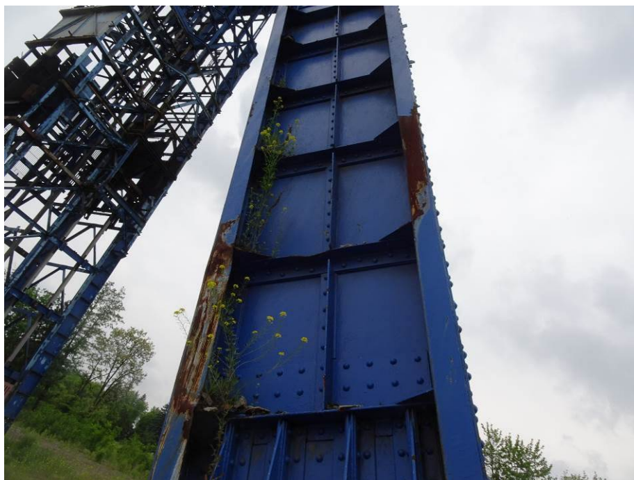
Rys. 25. Lokalne uszkodzenia korozyjne skosu
