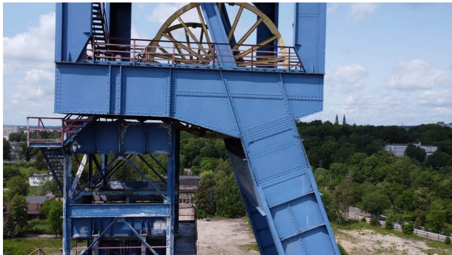
Rys. 52. Widok od strony wschodniej. Lokalna korozja i ślady po zaciekach
