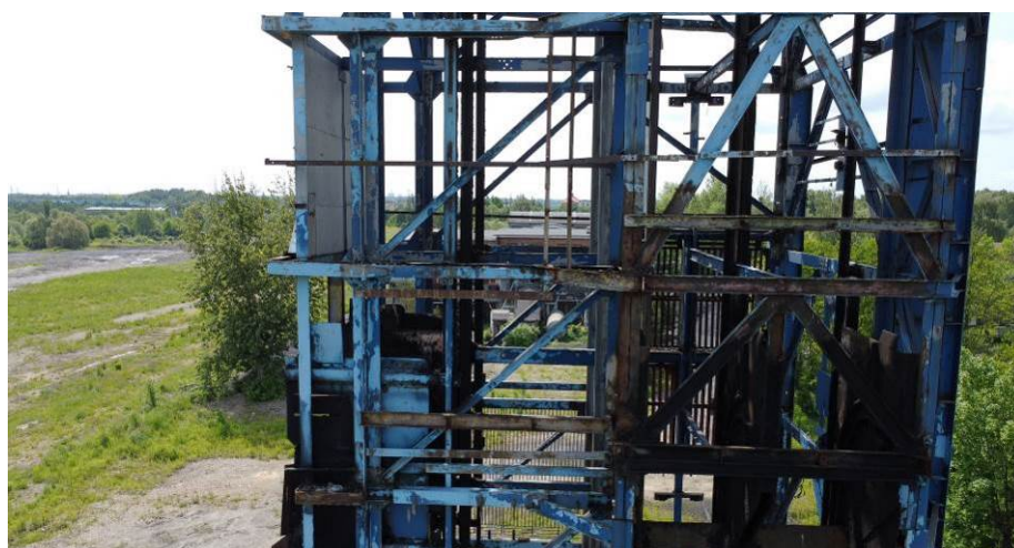
Rys. 61. Widok od strony północnej. Lokalna korozja
