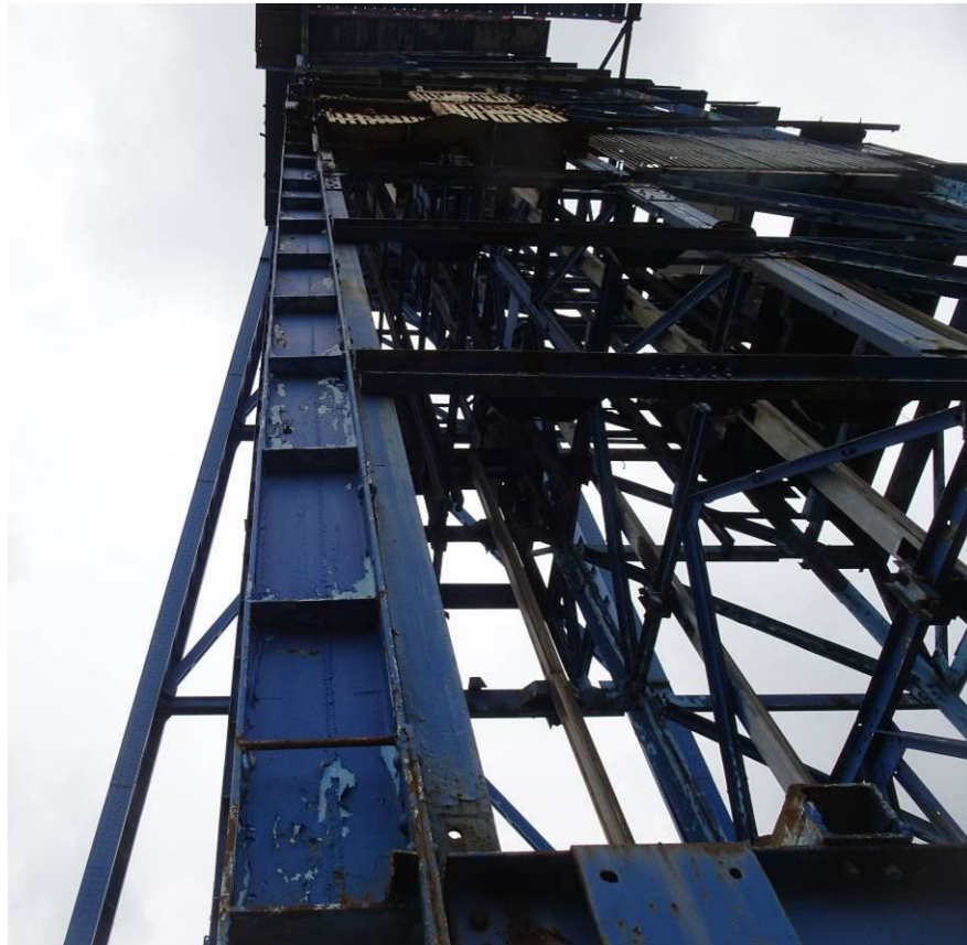
Rys. 19. Lokalne uszkodzenia korozyjne elementów wieży przewodniczej
