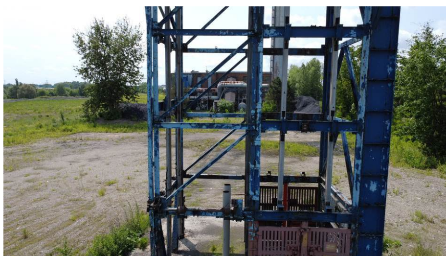
Rys. 64. Widok od strony północnej. Lokalna korozja
