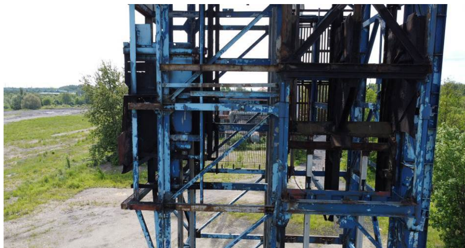
Rys. 62. Widok od strony północnej. Lokalna korozja
