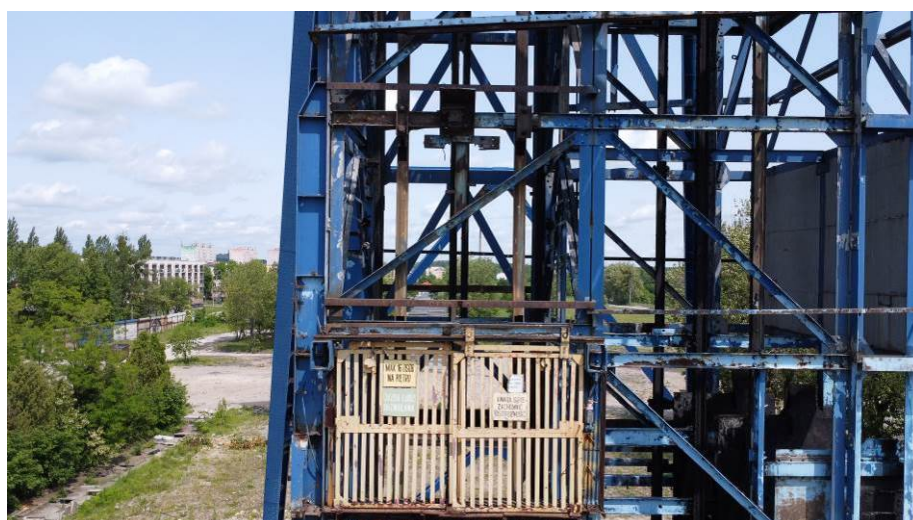
Rys. 47. Widok od strony południowej. Lokalna korozja
